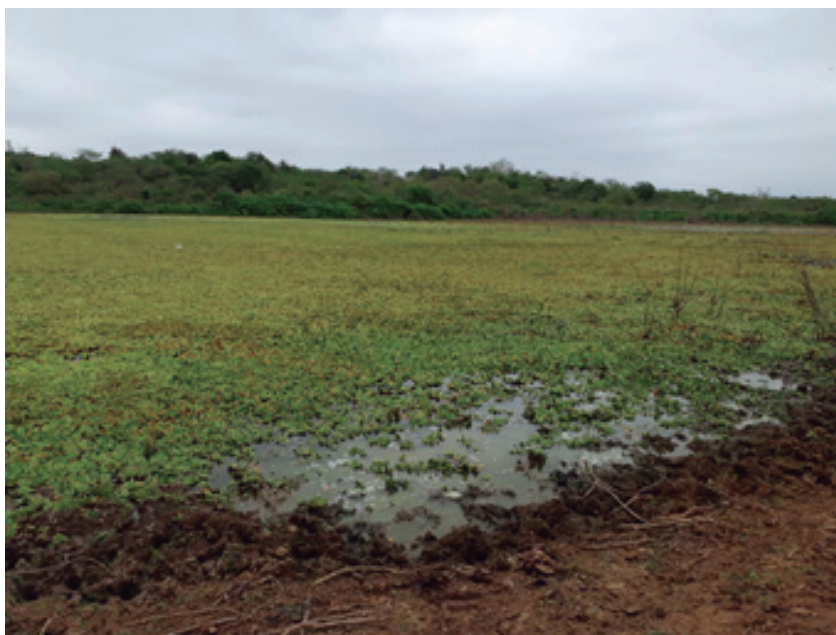
Foto 2. Albarrada en la comuna Ciénaga. Obsérvese el mal estado de conservación (Fuente: Autores, junio, 2018).
